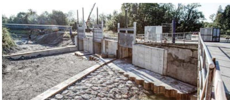
Die Sanierung unseres 3-Stufen-Wehrs konnte im September 2020 erfolgreich abgeschlossen werden. Im Rahmen dieses Bauabschnitts wurden die Schütze 5 bis 7 komplett saniert. Der sehr hohe Verschleiß und die Reparaturanfälligkeit der Bestandschütze hat dies erforderlich gemacht. Die Maßnahme dient vor allem dem Hochwasserschutz, welcher nun wieder
