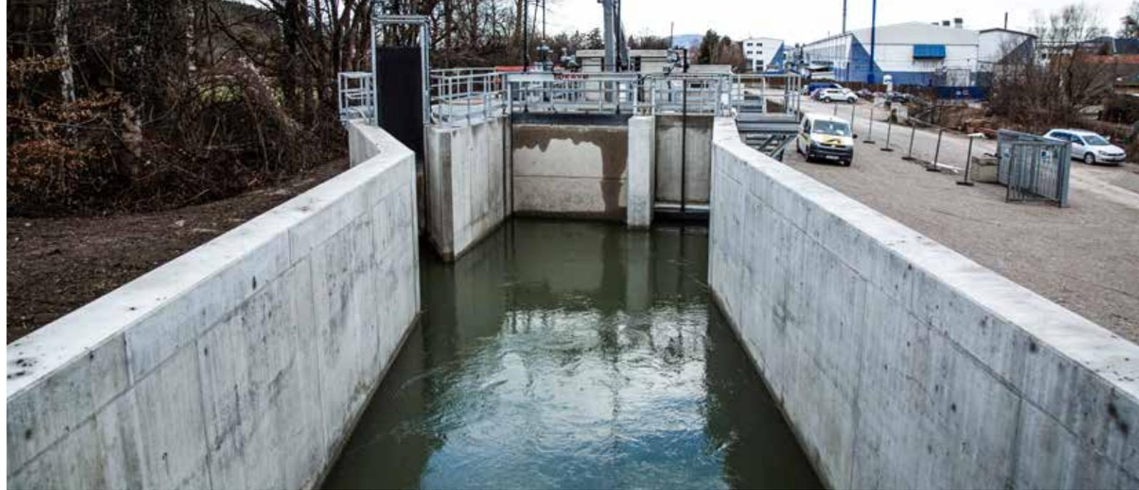
wir mit der kontinuierlich verfügbaren Wassermenge von  $4,9 \text{ m}^3 / \text{Sek.}$  in etwa 246 kW. Im Jahr erzeugen wir damit ca. 2.100.000 kWh, das entspricht dem Stromverbrauch von 500 Haushalten und verhindert so den Ausstoß von ca. 740 Tonnen  $\text{CO}_2$ .
